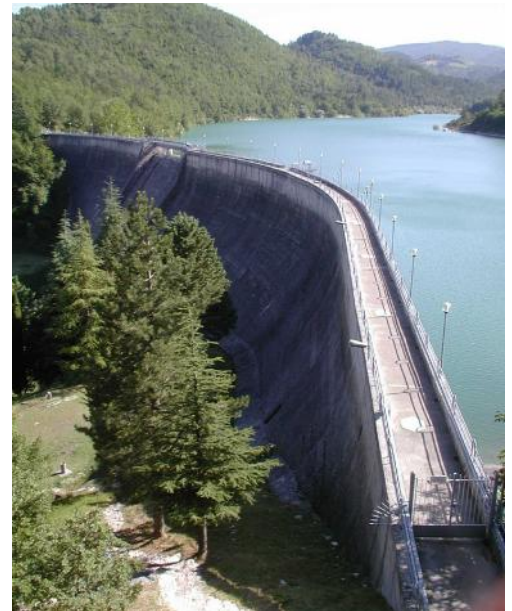
Diga sul T. Marroggia
