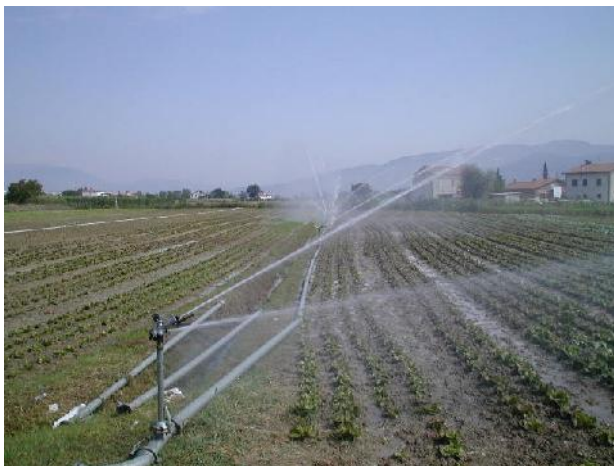
Sistema di impianto di irrigazione a pioggia
